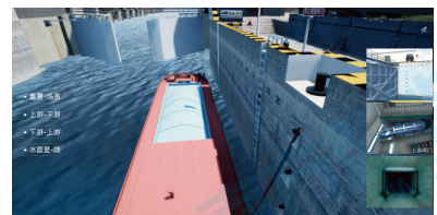
某数字孪生船闸试点工程
