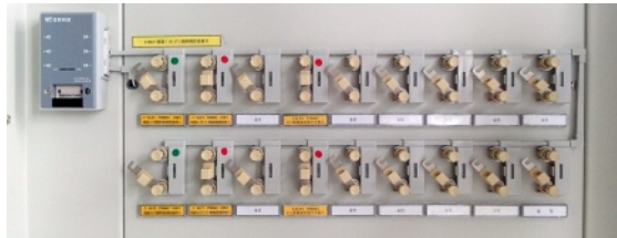
连片式压板现场安装图
