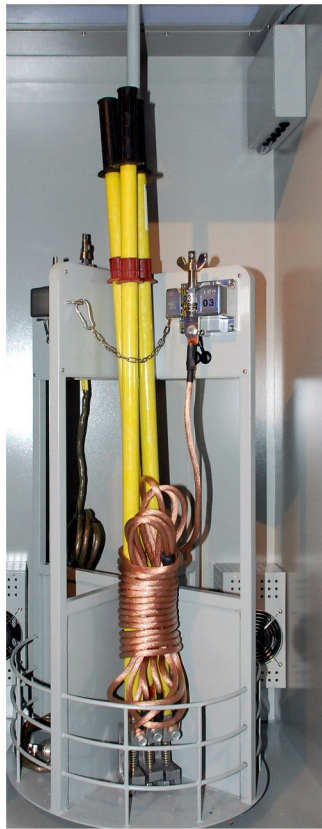
图4 闭锁机构将临时接地线的地线头闭锁
