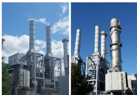
华润协鑫热电2×75MW燃气机组脱硝
