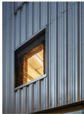
FREITAG 在胶州路店延续了其标志性的工业风格，在这种风格的基础上，又增加了一些新的元素。例如，银色金属隔板上的开窗位置参考里层的红砖墙窗洞，适当错位和调整大小，创造出多层次的框景效果。亮黄色的铁艺楼梯和银色的槽钢支撑、灰色的“再生砖”地板构成了鲜明的对比，给人强烈的视觉冲击。此外，店面内暴露的管线和荧光灯管被精心地排列在刷白的混凝土楼板上，既具有美感，又具有功能性。
