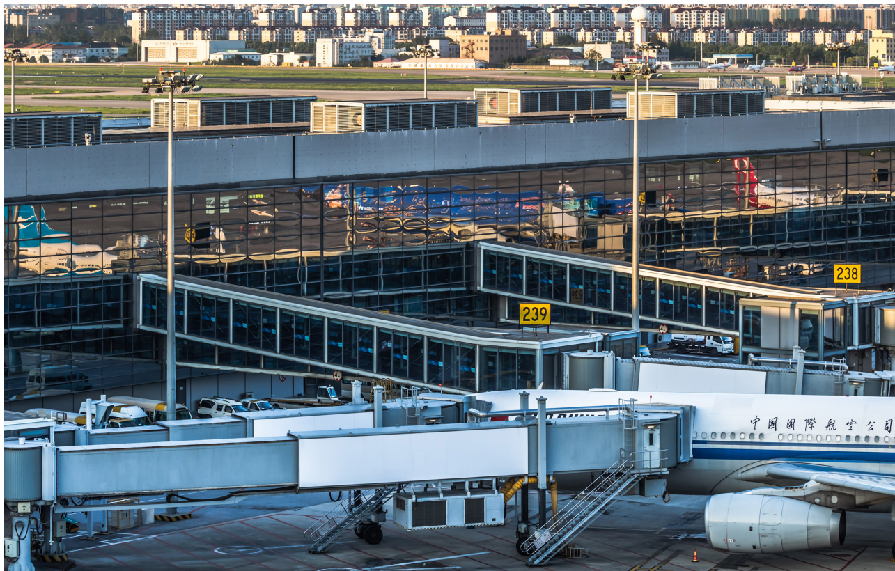
虹桥机场登机桥配备桥载电源
