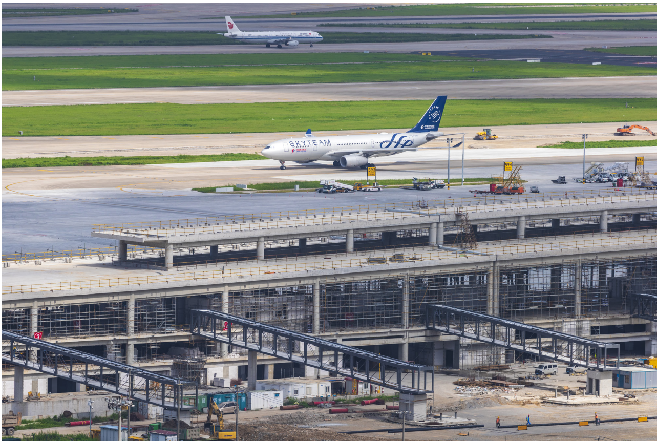
浦东机场卫星厅大面积落地窗、登机桥钢结构
