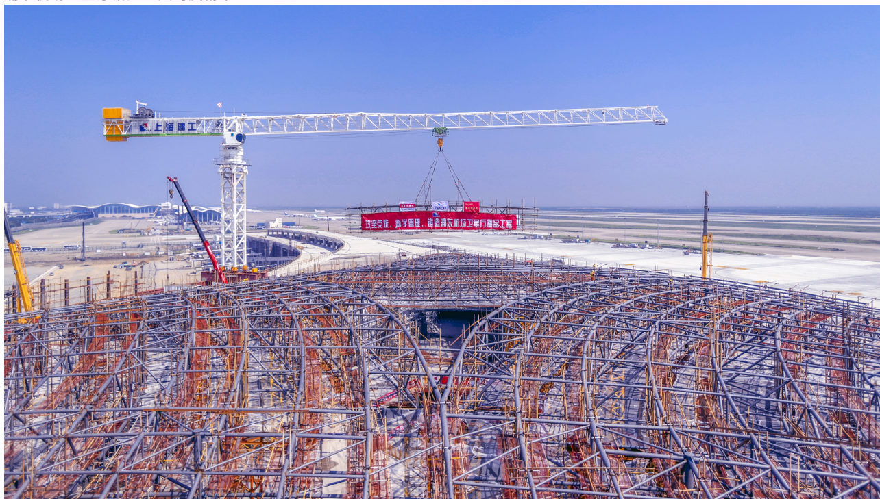
浦东机场卫星厅钢屋盖大跨度桁架
