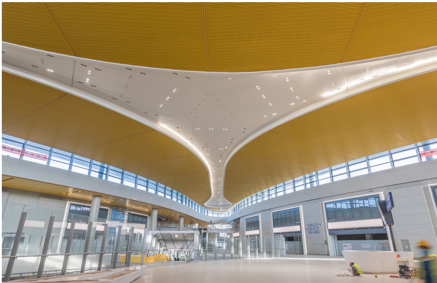
浦东机场卫星厅三角形大跨度钢屋盖
