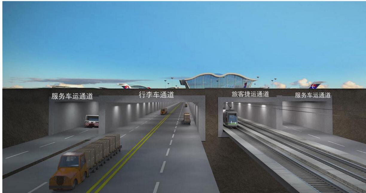
该工程位于浦东机场航站区与即将建成启用的卫星厅之间，于2014年12月开工，包含新建的7条下穿通道、2座滑行道桥以及5号机坪的改造。其中，T1航站楼至卫星厅S1之间、T2航站楼至卫星厅S2之间分别设有两根服务车道、1根行李车道，T2航站楼至卫星厅S2之间还有一条捷运车通道，形成联系南北航站区的地下快速通道。浦东机场现行的地面服务车道为南北向，与唯一一组东西向的垂直滑行道T3、T4平面交叉。而T3、T4是浦东机场最繁忙联络滑行道，浦东机场日起降航班700多架次，有近60%的航班穿梭其上，导致远机位与航站楼之间的行李车、摆渡车等待时间过长，尤其在航班高峰时，大大影响了远机位旅客的乘机体验。该工程建成后，远机位服务车辆将直接通过下穿通道穿越垂直滑行道，穿越时间缩短至2分钟左右，显著减少了远机位航班的摆渡时间，有效改善了远机位旅客的乘机体验，提高了机场整体运行效率和服务水平。
