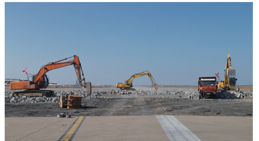
沥青道面集中破除作业
