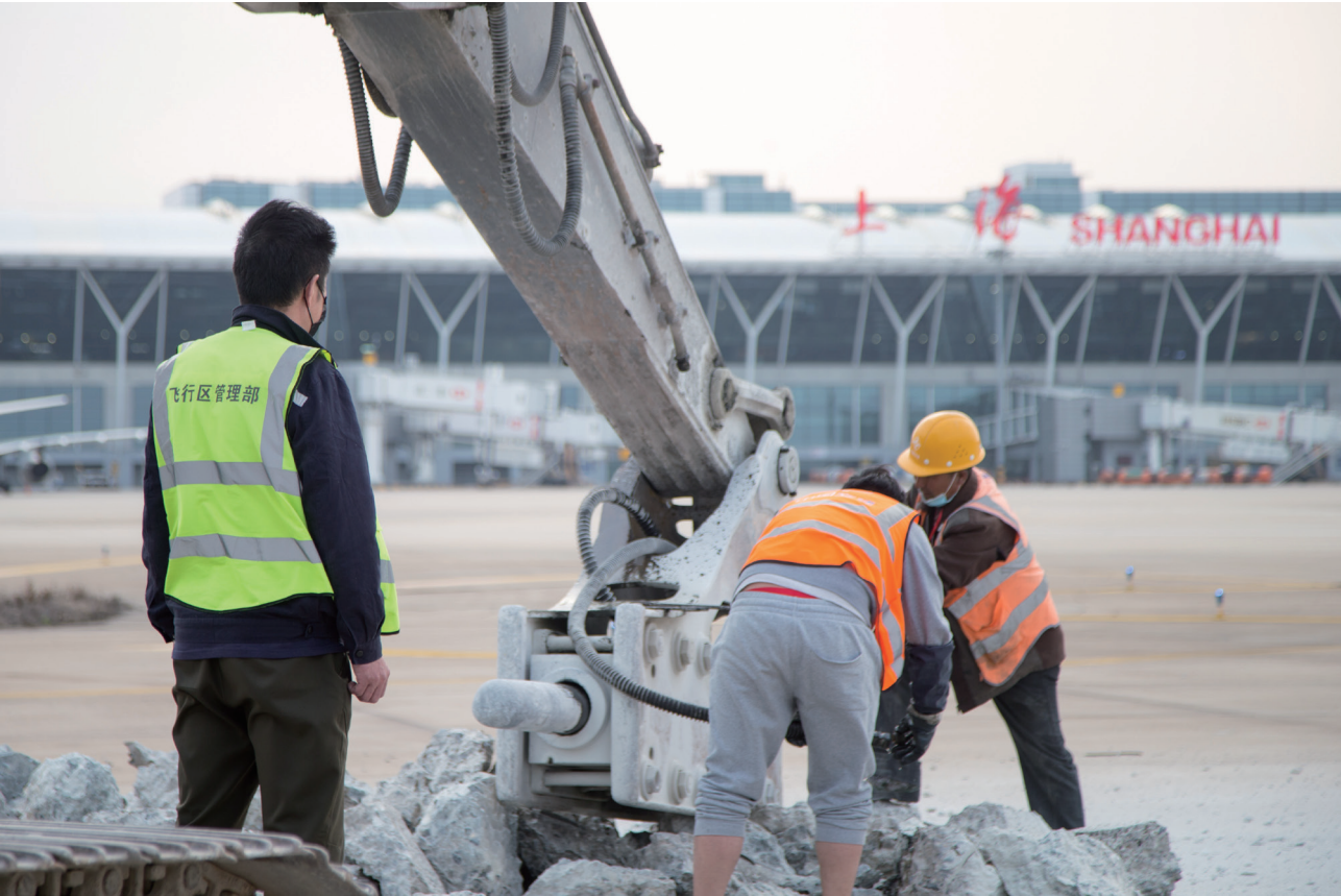
现场监管人员确认道板破除情况
