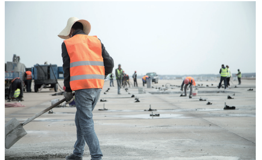
跑道道板基层注浆作业
