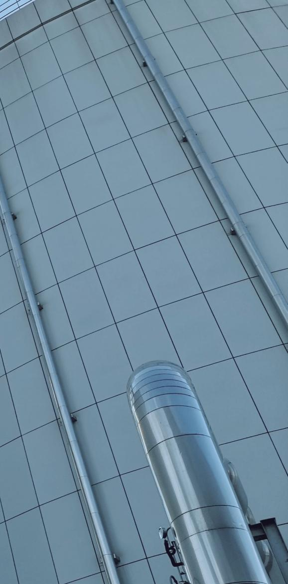
水蓄冷空调是通过低温水制备机组、水蓄冷罐和相关管网组成设备系统，在每天夜间的用电低谷期制备低温水，通常水温会控制在5℃左右，将其储存在制冷罐内，白天需要开启空调时，这些水就作为空调制冷的冷媒，通过管网进入空调，用于室内降温。低温水在完成空调冷媒作用、水温上升后，会通过管网回到制冷罐，用于下一晚继续制备。由于水的物理特性，不同温度的水密度不同，5℃的低温水密度高于使用后的高温水，因此能够在同一空间之中分层布局，水低温向下、高温向上的对流特点，也使得高温回流水和低温水在同一个水蓄冷罐内可以同时存储而继续实现冷媒的作用。
